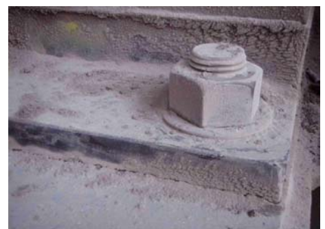
Detalle pernos de fijación del soporte
